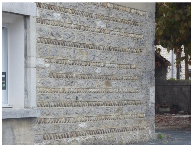
Soubassement de pierre et de galets roulés et assemblés en arêtes de poisson à Druillat (Urbicand)
