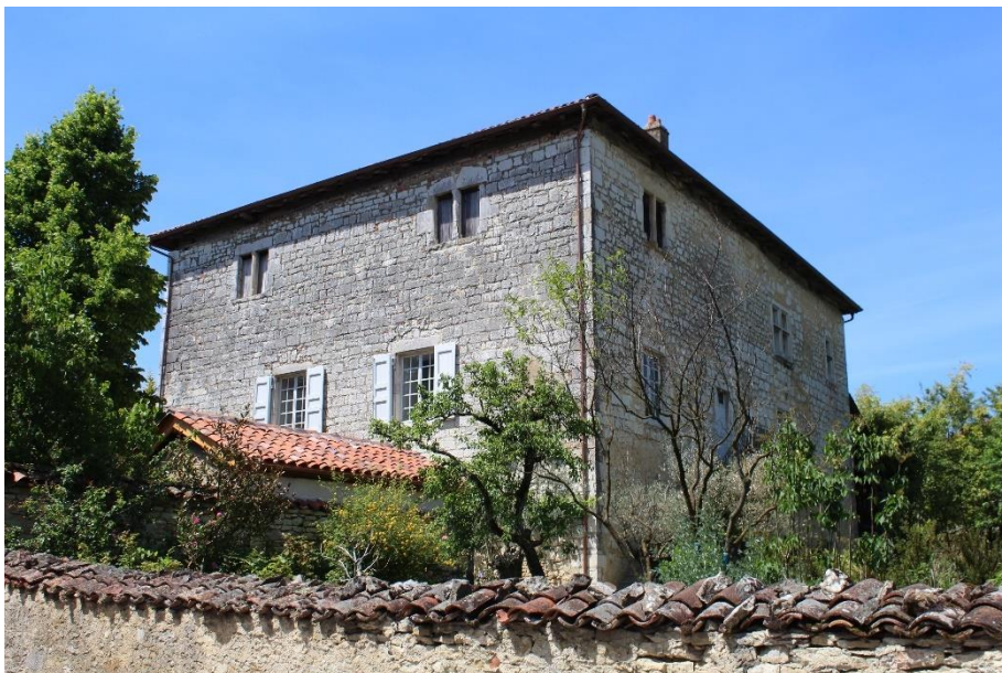
Maison forte de DEAUL - Revonnas (Source : Wikipédia)
