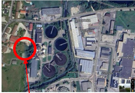
Unité de production d'énergie complémentaire
