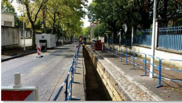
Tranchée pour réseau de chaleur
