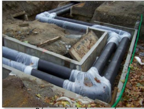
Réseau de chaleur posé
