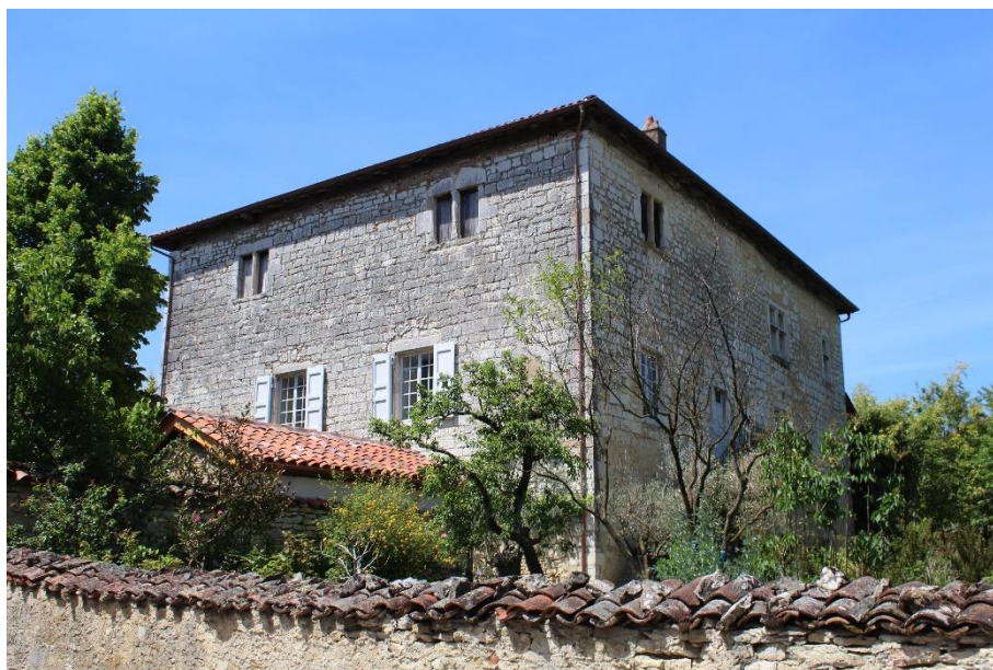
Maison forte de DEAUL - Revonnas (Source : Wikipédia)
