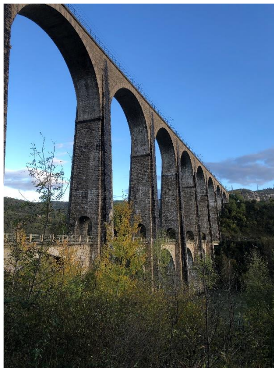
Viaduc de Cize-Bolozon (Urbicand)
